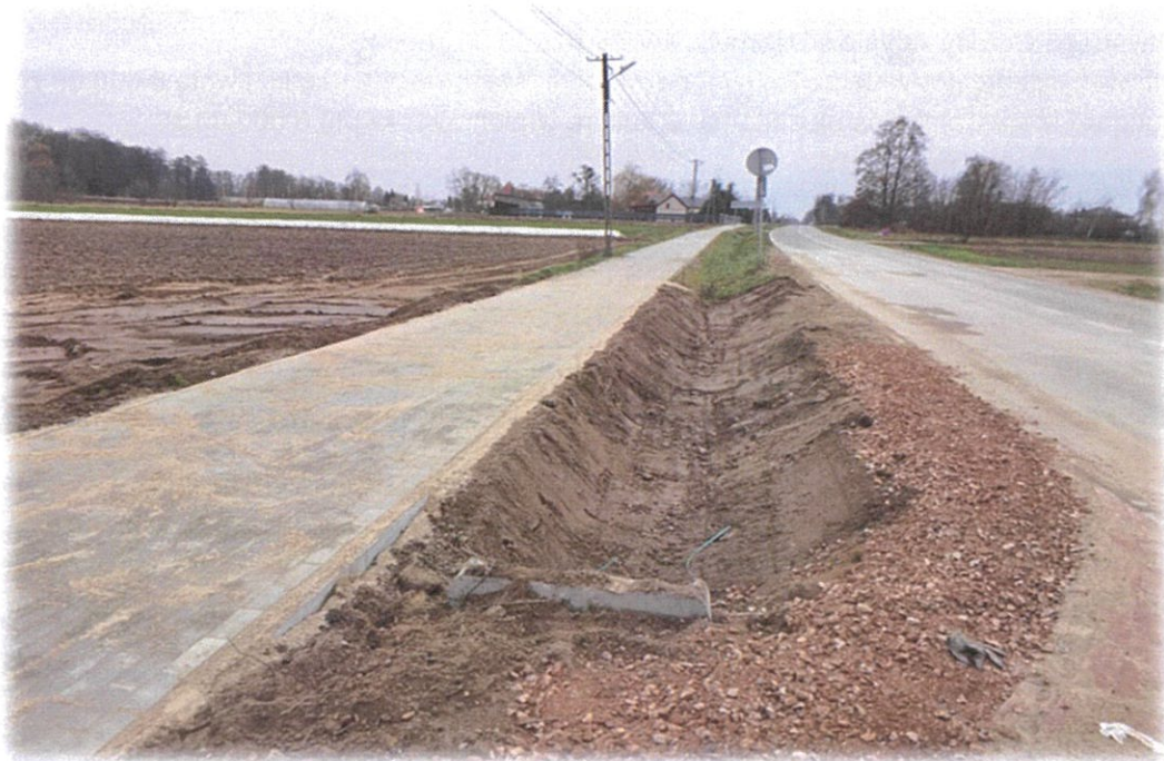
Rozbudowa DP 4115W ul. Północnej na odc. 343 m w m. Bramki i Wola Łuszczewska, gm. Błonie
