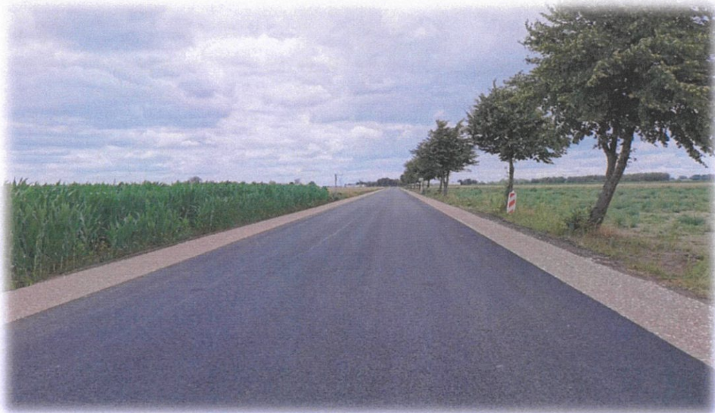
Rozbudowa drogi powiatowej nr 2420W ul. Rolniczej – etap 1 o dł. ok. 1600 mb, gm. Łomianki.
