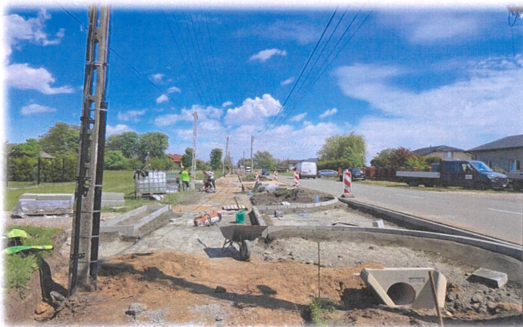
Wykonanie nakładki asfaltowej na drodze powiatowej nr 4120W ul. Nowowiejskiej o dł. ok. 2100 mb od skrzyżowania z DW nr 888 do granicy z gminą Leszno w m. Pilaszków, gm. Ożarów Mazowiecki.
